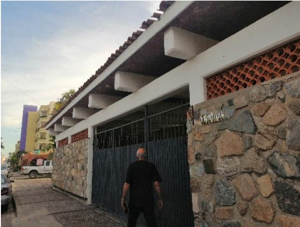
Fig. 3 Casa Mackenzie, fachada, donde se aprecia el manejo de materiales regionales, así como el uso de su característica ventana natural formada por el descanso de la viga de concreto y la cubierta, elemento que lo realizó en diferentes obras. Fotografía LAMP 2020.
