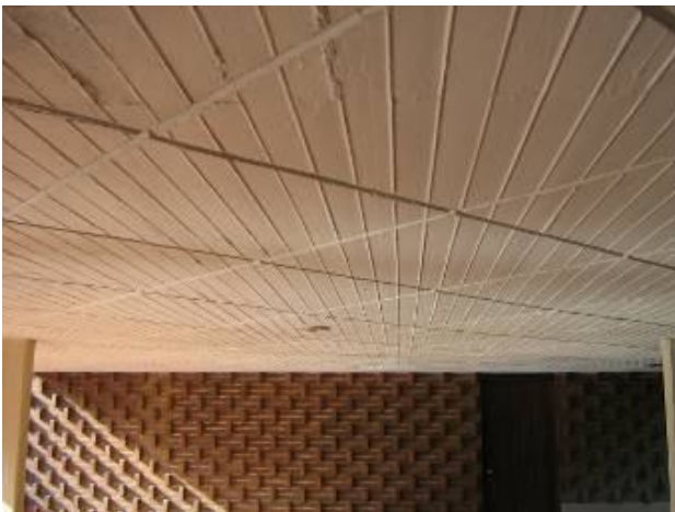
Fig. 12 y 13 Detalle del plafón donde se aprecia la duela del barco Cacalilao y las diagonales que puso el arquitecto para acentuar su textura. Así como el remate visual de corredor. Fotografías LAM, 2009
