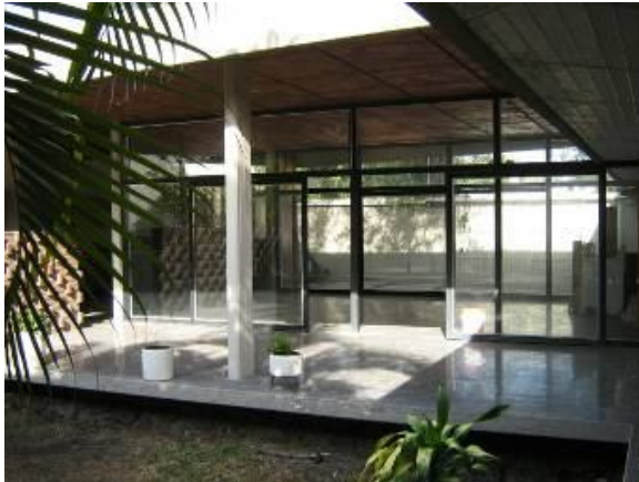
Fig. 9 y 10 Vista de la zona de día, sala, comedor, que mirando el patio jardín central y el ingreso a la residencia. Tratamiento de piso de mármol con cubierta de losa de concreto con plafón de piso de pasta de cemento en formación de petatillo. Fotografía LAMP. 2009.
