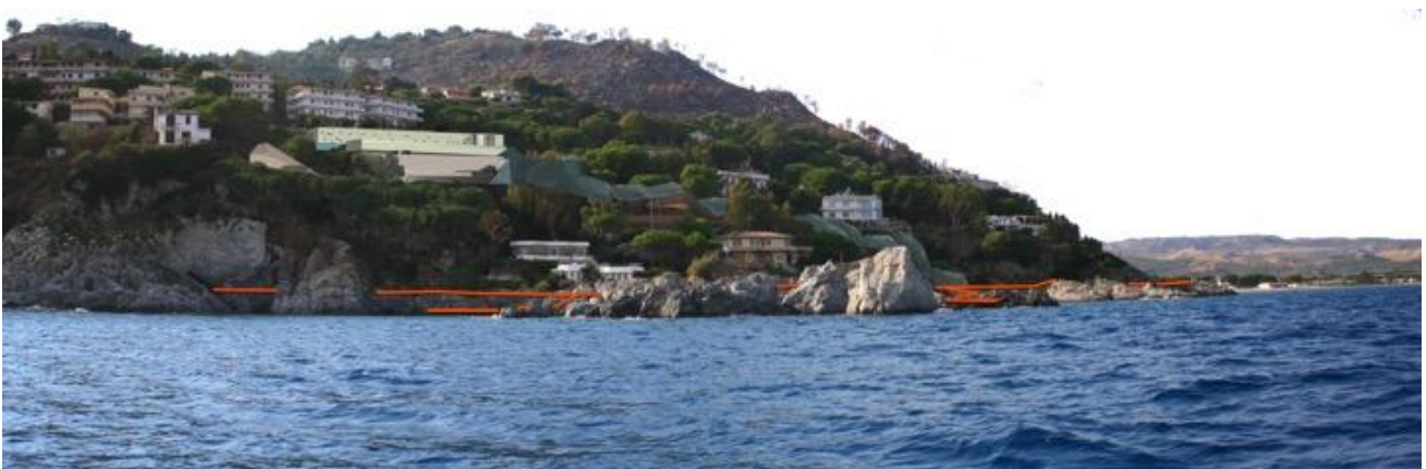
Staletti. Località Copello. Vista dal mare prima e dopo l’intervento di demolizione e riconfigurazione della costa.
