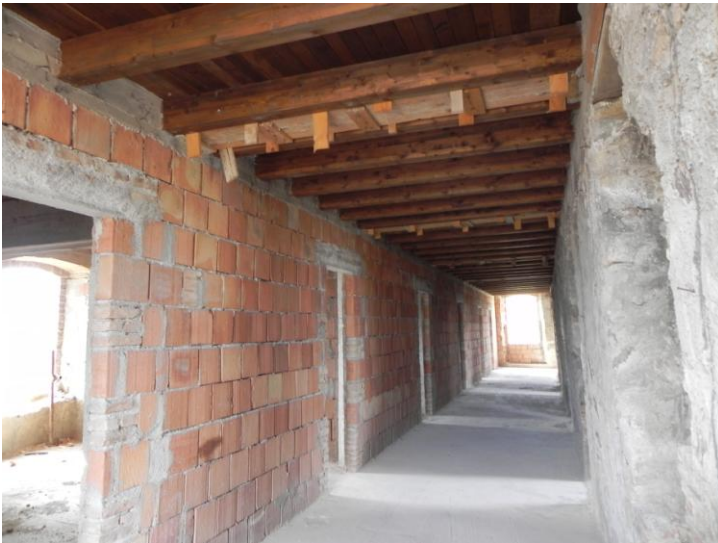
5. Secondo piano della parte conventuale completamente ricostruita. Ex celle dei monaci.
