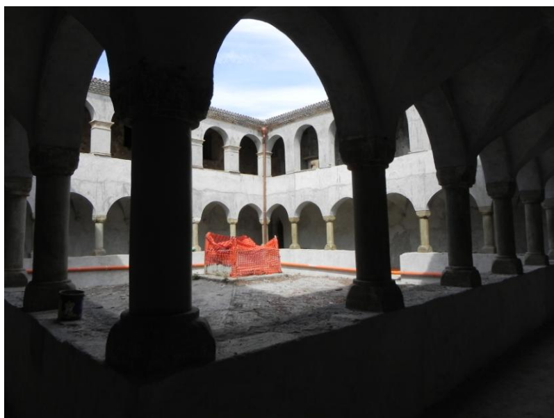
4. Chiostro del convento dopo una tranche dei restauri.
