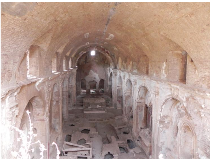
6. Interno della chiesa, foto fatta verso l'abside. Pavimento distrutto dalla profanazione delle tombe.
