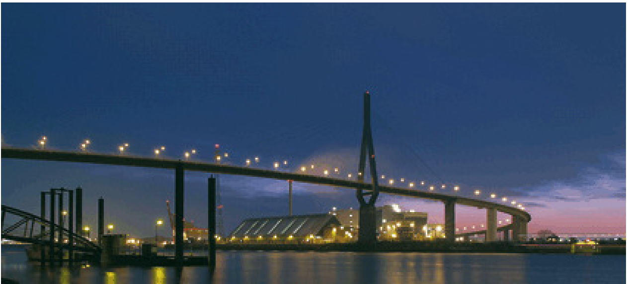
Figura 4: Vista laterale del ponte.
