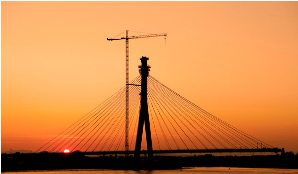
Figura 1: Ponte strallato di Waterford, 2009.
